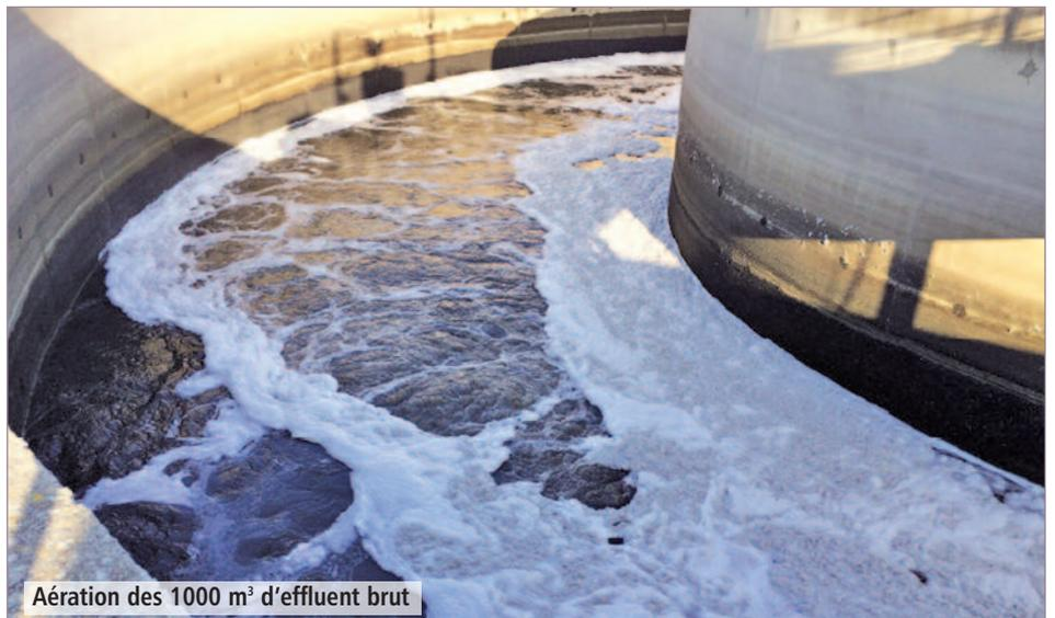
Aération des 1000 m<sup>3</sup> d'effluent brut
