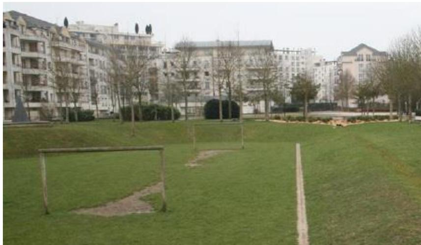
Figure 6 : Terrain de sport dimensionné pour la rétention des eaux pluviales (source: Cerema)
