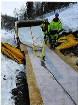
Fig. 5 – Installation d'un Alphasliner par des températures négatives en Norvège
