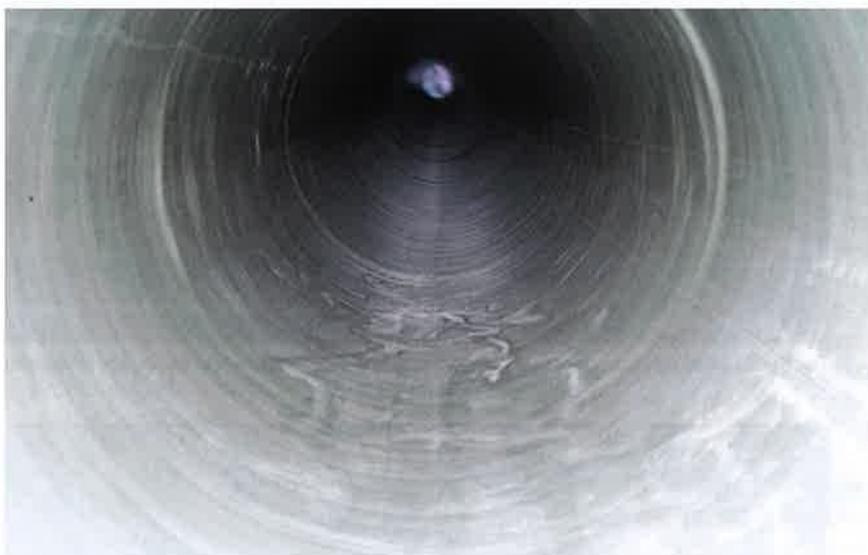
**Fig. 10 – Gaine AlphalinerPN installée dans une conduite d'eaux usées sous pression à Berlin**
