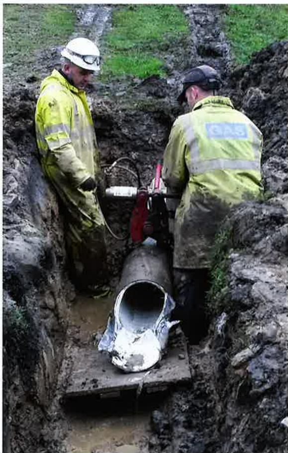
Fig. 12 – GasLiner dans une conduite de gaz
