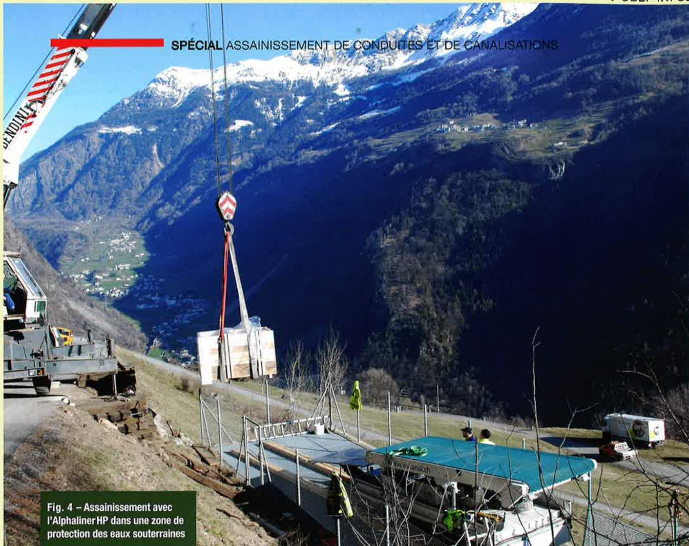
**Fig. 4 – Assainissement avec l'Alphaliner HP dans une zone de protection des eaux souterraines**
