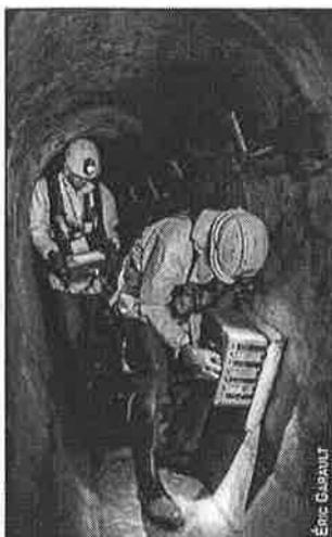
Figure 7. Passage d'une antenne radar en réseau
