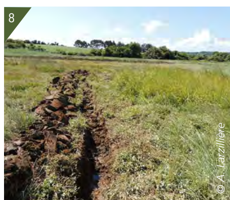
5, 6, 7 et 8 - Creusement d'une tranchée.
