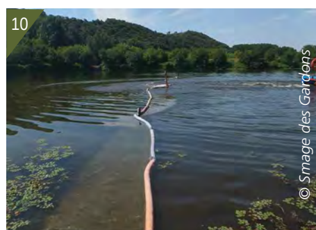
7 et 8 - Opérations d'arrachage mécanique : engin faucardeur amphibie et radeau d'évacuation des résidus (figure 7) et bateau grue et radeau (figure 8). 9 - Graines libérées des sédiments. 10 - Mise en place de filets pour éviter la dispersion des fragments de jussie lors de l'arrachage mécanique.
