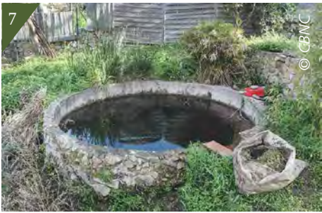
7 - Le bassin de Lumiu après intervention.
