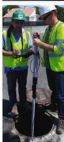
SewerBatt se présente comme une sonde portable fixée sur une canne télescopique que l'agent introduit au fond du regard.
