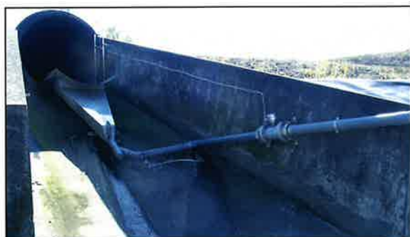
Figure 6. Dispositif pour le mesurage des faibles débits ( leaping weir et débitmètre électromagnétique)
