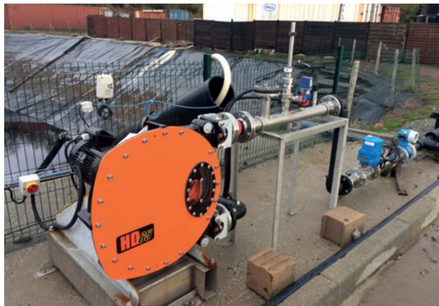
Les pompes Abaque, conçues et fabriquées par Mouvex, répondent aux exigences du transfert de boues et offrent une hauteur d'aspiration allant jusqu'à 9 mètres. Elles peuvent tourner à sec sans impact négatif sur les performances, sur le niveau de pression ou sur la précision. Elles offrent une pression de refoulement supérieure, allant jusqu'à 16 bar.
