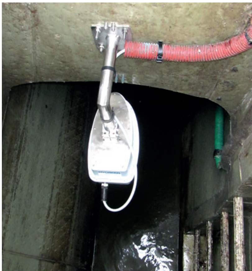
Le débitmètre radar sans contact SurfaceFLO d'Hydreka est muni de sorties analogiques 4-20 mA et numériques RS485 ModBus / SDI-12.
