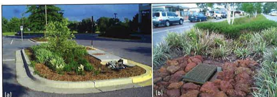
Figure 7. Exemple d'un ouvrage typique (a) de biorétention aux États-Unis (NCDWQ avec permission) et (b) de biofiltration en Australie (Emily Payne, Monash University, avec permission)
