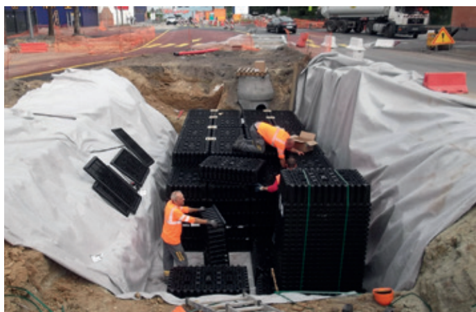
Figure 1: Exemple de réalisation pendant et après travaux: Boulevard Bréguet à DOUAI (Utilisation de structures alvéolaires ultra-légères implantées sous les espaces verts).
