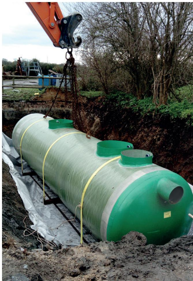
Décanteur particulière avec châssis-speed réalisé en PRV sur-mesure (débit de traitement: 54 litres/seconde). Réalisation Simop.
