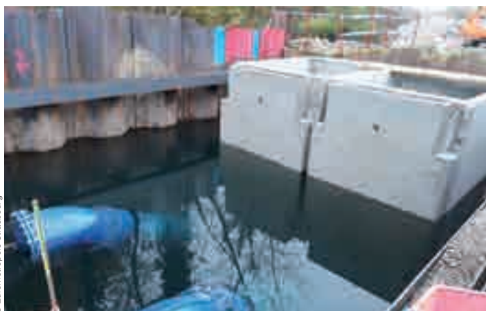
La création des six forages a démarré en novembre dernier.
