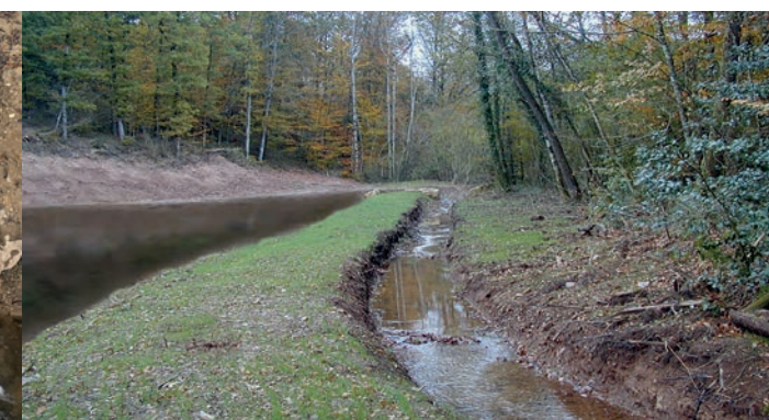
EXEMPLE DE CRÉATION D'UN NOUVEAU LIT EN DÉRIVATION D'UN PLAN D'EAU SUR LE BASSIN DE L'ALZOU (ROUSSENNAC)
