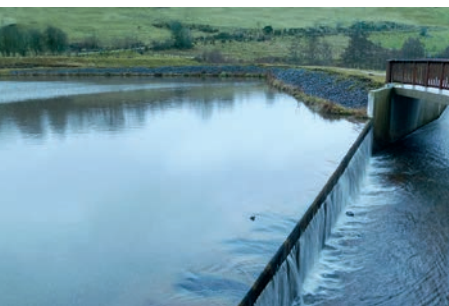
DÉVERSOIR DE CRUE SUR LE PLAN D'EAU DE CANTOIN (NORD AVEYRON).
