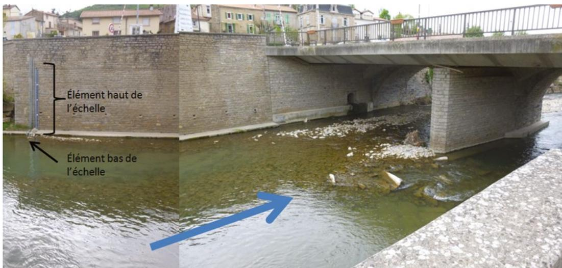
Figure 2 : Échelles limnimétrique à la station
