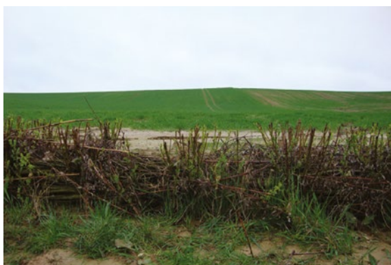
Photo N° 6 : Fascine perpendiculaire à l'axe d'écoulement avec dépôt sédimentaire en amont (Areas 2011 Veauville)
