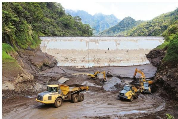
Figure 4 : Exemple d'opération de curage dans une retenue de barrage (©Jean-Luc Massinon)
