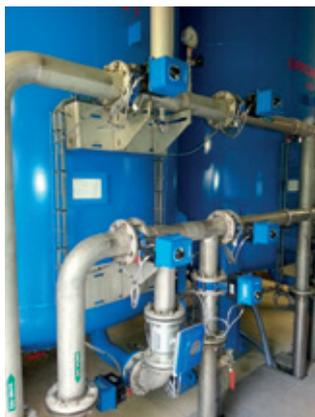
Figure 2: Filtres à charbon actif en grain.
