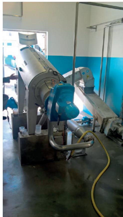
Cette presse à vis Huber technology Q-PRESS 280, installée en Martinique, déshydrate les boues issues du traitement des eaux usées d'une usine de mise en bouteille de boissons gazeuses (SNEMBG) et d'une usine de fabrication de glaces (Miko). Avec un conditionnement des boues adéquat ( $\text{FeCl}_3$ , NaOH et polymères), les boues atteignent 18 % de siccité en sortie.
