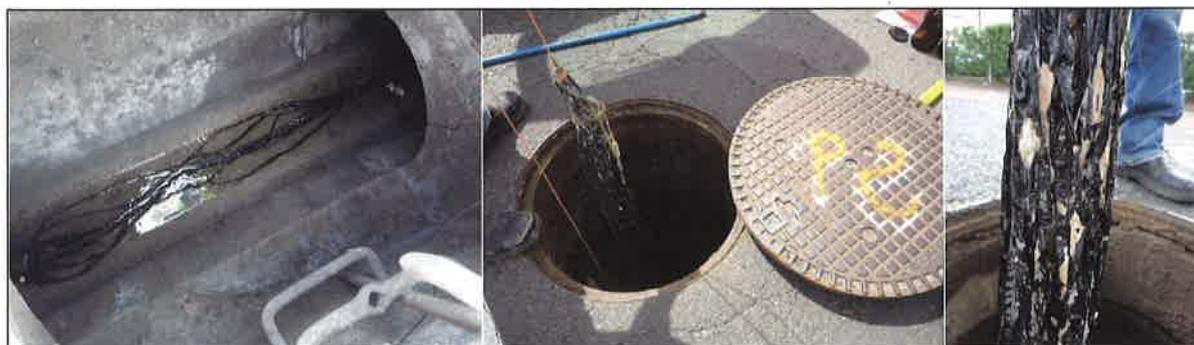
Figure 4. Mise en place de la pieuvre dans un réseau
