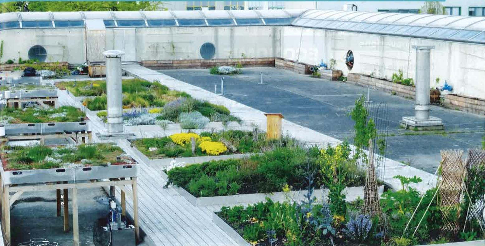
de plus de 2 l/s/ha, soulageant les ouvrages en aval (déversoirs, stations d'épuration...). En comparaison, la toiture conventionnelle sature et déverse selon des débits très irréguliers de 5 à 50 l/s/ha à douze reprises pendant l'année d'observation. En outre, aucun débordement n'a été noté avec la solution HydroVentiv.
