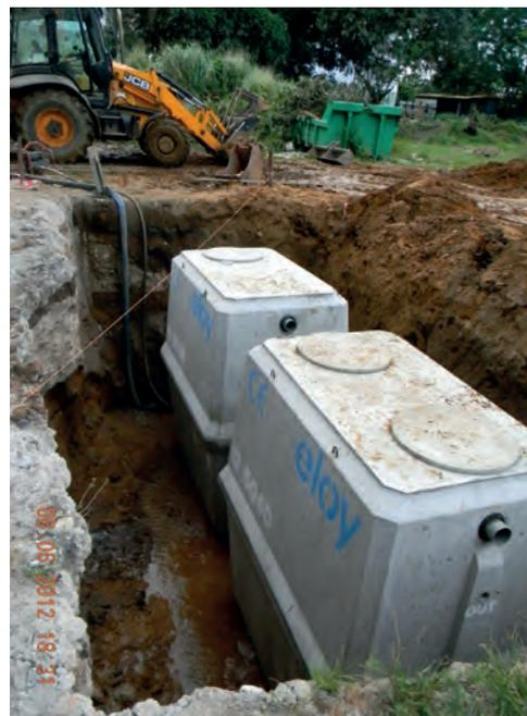
La microstation d'épuration Oxyfix<sup>®</sup> d'Eloy Water (jusqu'à 350 EH) repose sur le principe du traitement par culture fixée immergée et aérée. Elle est disponible en deux matériaux, béton ou polyester renforcé de fibres de verre, en fonction du terrain.
