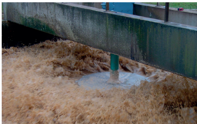
Aquameco conçoit et fabrique des turbines lentes ou rapides d'une puissance de 1,1 à 45 kW. Elle propose également des turbines rapides en location pour répondre à des besoins ponctuels.
