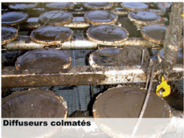
Remplacement complet du réseau Station d'épuration de Meaux
