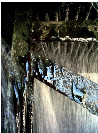
Figure 2: (a) Image de l'intérieur d'une tour de refroidissement avec un biofilm et (b) d'une plaque de culture avec présence de bactéries Legionella .
