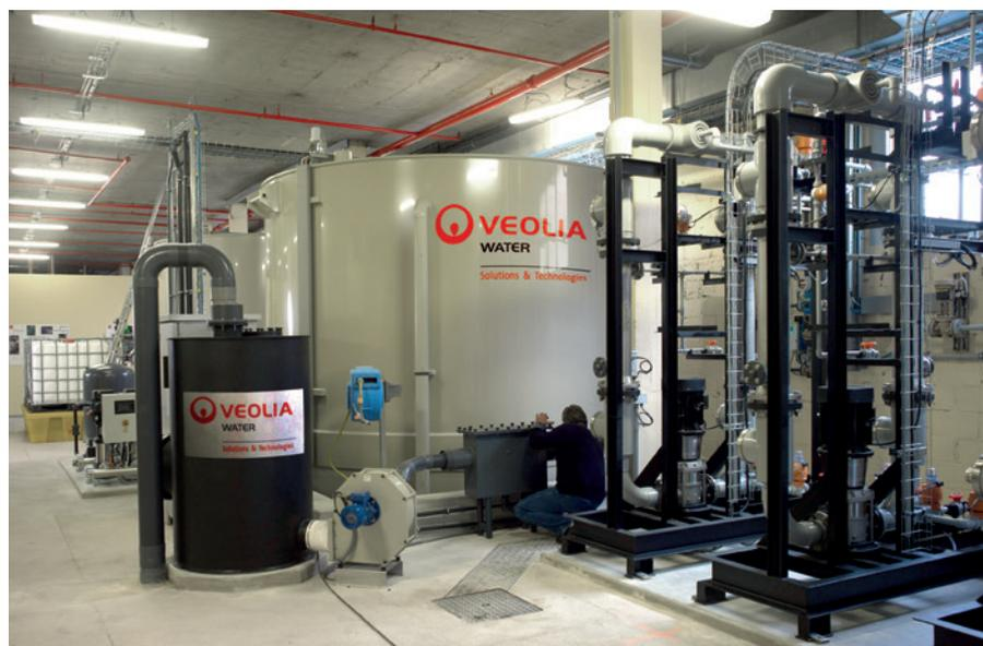
**Installation de recyclage des eaux d'étuves chez un grand industriel de verres optiques. L'eau recyclée est directement réutilisable en production. Réalisation OTV DBI.**
