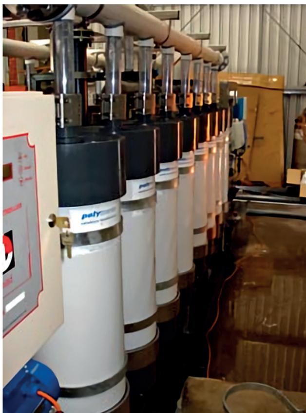
Traitement tertiaire des eaux usées industrielles (UF avant RO) pour la réutilisation. Smith Snackfood, Australie, 1 760 m<sup>3</sup>/j. Réalisation Polymem.
