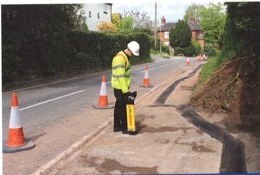
Le Leica Digicat 750I xf Smartready est un outil d'évitement de réseaux facile à utiliser. Il intègre la technologie GPS, l'enregistrement des données et le Bluetooth® pour détecter les installations sur de longues distances.
