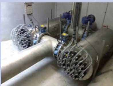
caractéristiques de chaque application. Les UV en réacteurs fermés sont plus adaptés pour le traitement d'eau potable, eau industrielle ou pour la réutilisation d'eaux usées et les systèmes par canal ouvert sont adaptés pour être installés facilement en eaux usées avant
