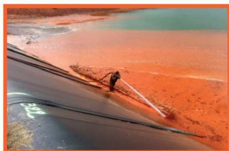
Doublage géomembrane PEHD en bassin industriel sans vidange
