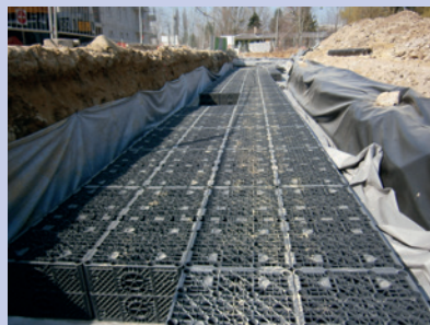
Bassin type SAUL enterré de 500 m 3 réalisé par Aquagéo Etanchéité, réalisé avec Eiffage. Une géomembrane polypropylène a été appliquée par un soudeur certifié Aqual.
