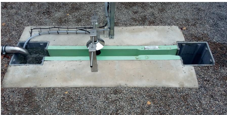
Aqualabo Contrôle propose une large gamme de canaux venturis permettant de s'adapter à tout type de canalisation. L'Aqua Venturi, ci-dessus, est un canal de jaugeage préfabriqué normalisé ISO 4359. Il est disponible en 8 modèles de 7 à 2 500 m<sup>3</sup>/h et s'adapte à toutes situations et aux eaux les plus chargées.
