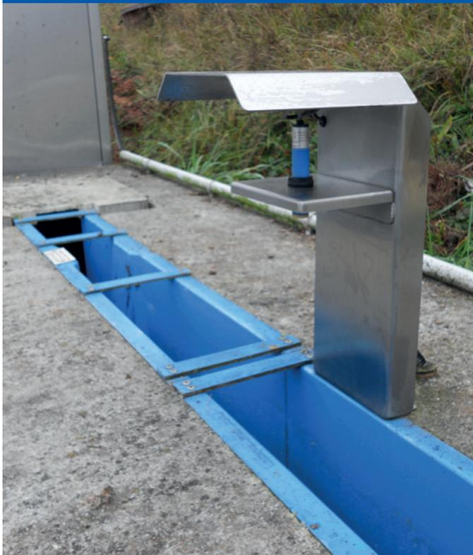
Endress +Hauser propose une large gamme de canaux Venturi à section rectangulaire allant de 1,5 m<sup>3</sup>/h à 2 200 m<sup>3</sup>/h.
