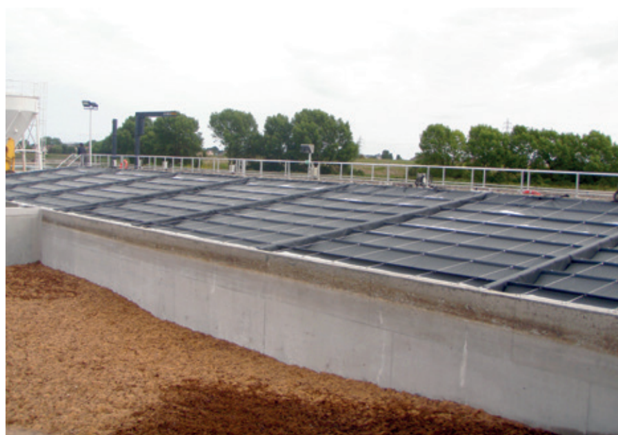
Couverture coulissante, 17 couvertures, 700 m 2 , Cabourg (France). Réalisation Ciffa Systèmes.
