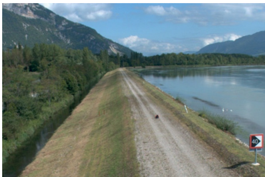
Figure 4 : Vue aérienne de la digue de la palière.
