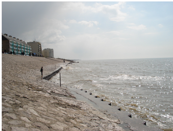
Illustration 8 : Perré à Wimereux (62) s'étant substitué au trait de côte (Photo : CETMEF)
