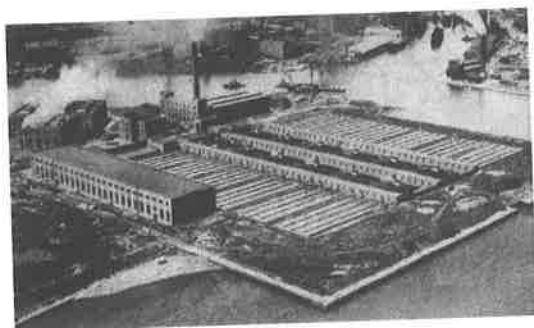
Fig. 3. La station d'épuration à boues activées de Milwaukee sur le lac Michigan.
