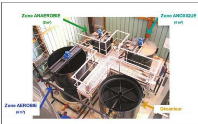
Figure 5. Photo du pilote installé sur le site de Seine-Aval
