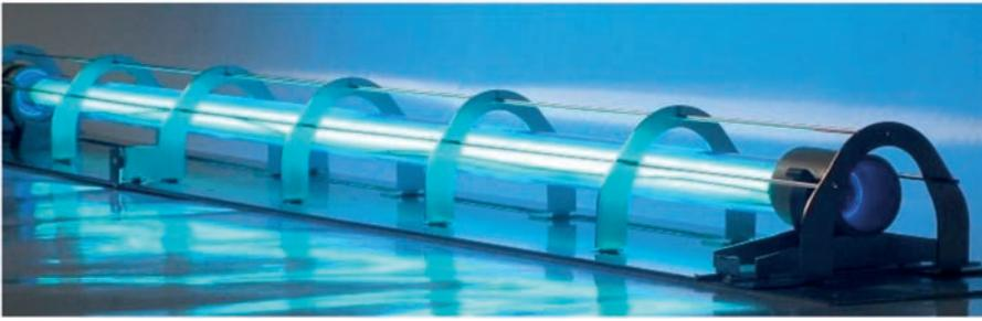
Figure 1: Le rayonnement UV: installation de lampes UV dans le bassin de la tour.
