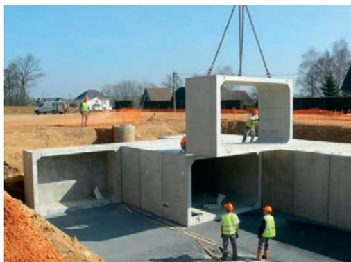
L'ECOBASSIN® allie maîtrise du savoir-faire et performances techniques avec une simplicité de pose et une résistance inégalée. L'ECOBASSIN® est une solution béton originale avec joint d'étanchéité breveté incorporé.
