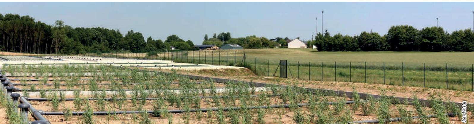
**Jean Voisin a mis en service à St Amand-Longpré (41) une installation de 2 300 EH en ajoutant un réactif chloroferrique (FeCl<sub>3</sub>) pour respecter un rejet de phosphore total à 2 mg/l. Le premier bilan 24h, réalisé fin 2015, était de 0,93 mg/l.**
