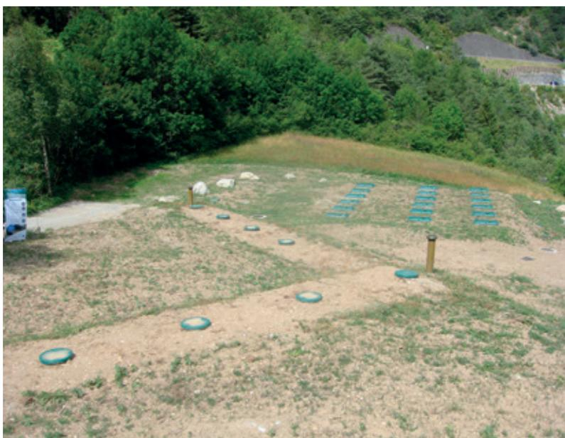
**Cette station de traitement des eaux usées collective pour 250 EH dans la Vallée de l'Ubaye respecte l'environnement alpestre avec une fiabilité remarquable. Le process de filtration utilisé s'applique avec efficacité pour l'ANC d'une maison individuelle.**
