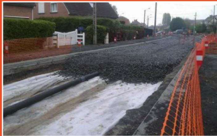
Mise en œuvre d'une chaussée réservoir dans le cadre d'une réhabilitation de voirie - CUNCY (59)
