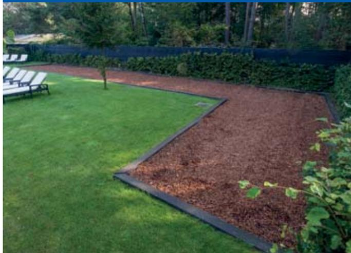
filtre compact dans son environnement. La présence d'un poste de relevage permet au Cocolit® de tamponner les eaux et d'anticiper les pics d'occupation ce qui en fait une solution adaptée aux applications touristiques. Le poste de relevage est géré par son armoire de commande qui limite la consommation d'énergie. La surface du lit filtrant se limite à 0,7 m<sup>2</sup> par habitant.
