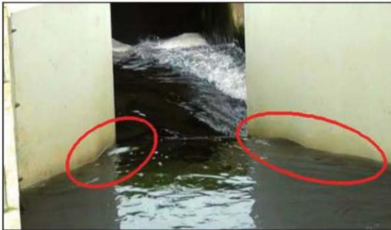
Figure 2. Parois gondolées dans la zone convergente d'un canal Venturi
