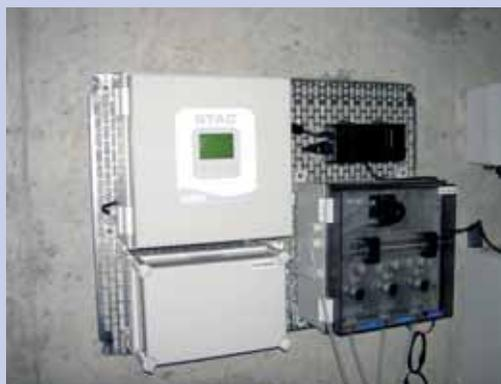
La Station d'Alerte Compact dispose de 4 à 8 sorties analogiques permettant le report des informations qualitatives (informations d'alerte sur la propreté de la cuve et sur des pollutions accidentelles) et des concentrations des paramètres estimés et mesurés.
