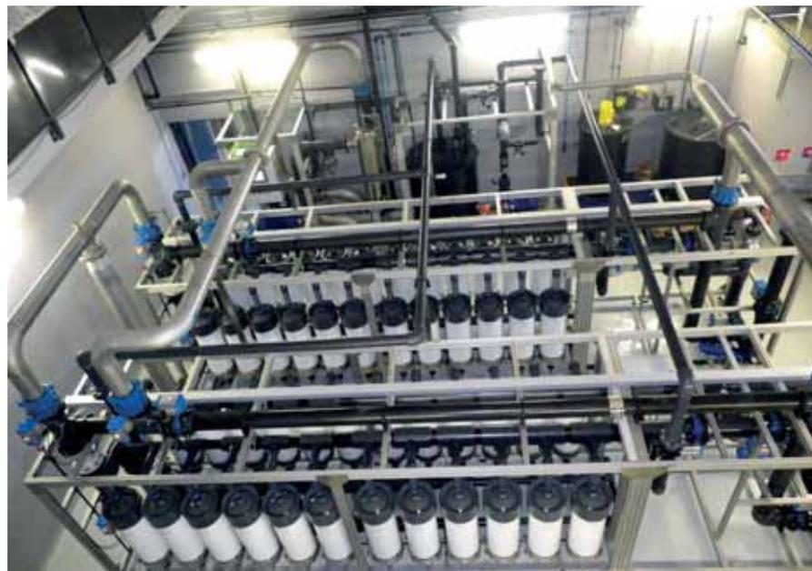
La Gamme Ultramem de Polymem est composée de modules fonctionnant en filtration en mode frontal Externe/Interne et offrant des surfaces de filtration de 4,5 à 114 m<sup>2</sup>.
