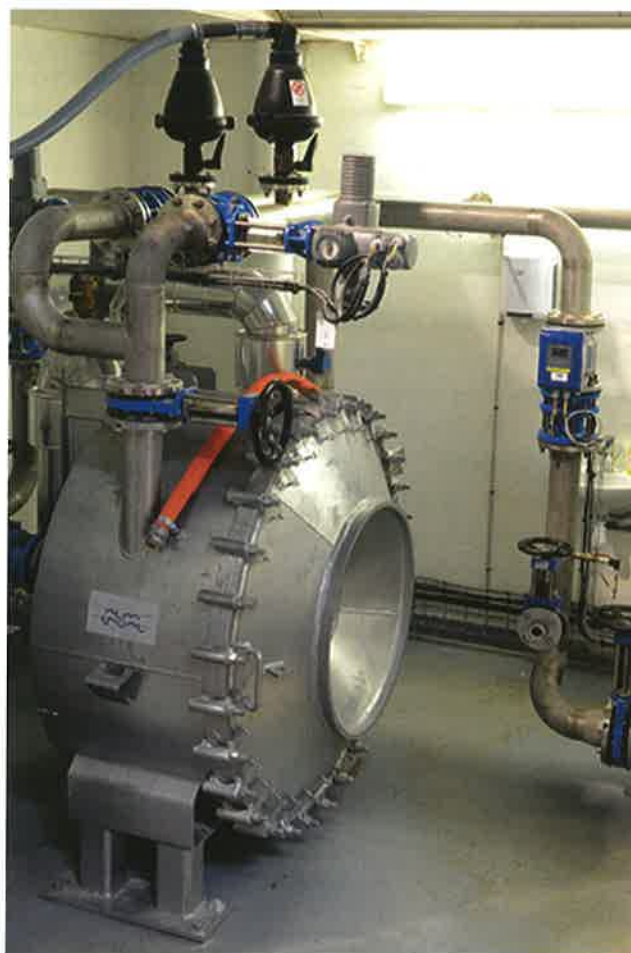
Figure 2: Échangeur spiralé 130 kW.
