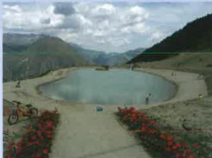
L'étanchéité de ces réserves est assurée par des géomembranes en PVC, EPDM, PP ou PE développées par Firestone, Serge Ferrari, Renolit Alokorgeo, Naue Applications ou encore Axter.
