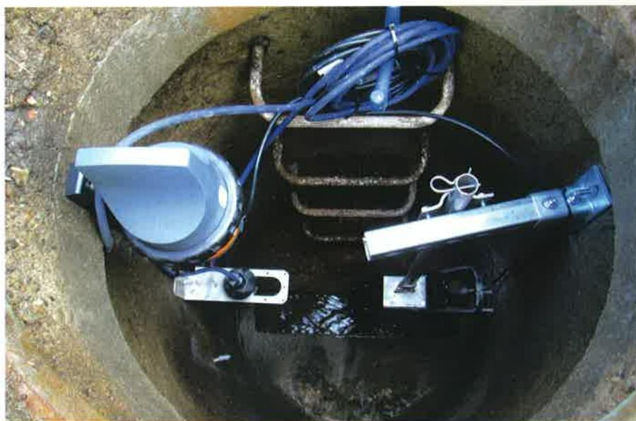
Compte tenu de la forte demande en appareils autonomes dans le cadre de la mise en place de l'autosurveillance des réseaux d'assainissement, Cometec propose une combinaison associant soit son radar sans contact « le Raven Eye », soit son débitmètre doppler, « le beluga », associé avec le LT42 de Lacroix-Sofrel, solution déclinée en deux versions.
