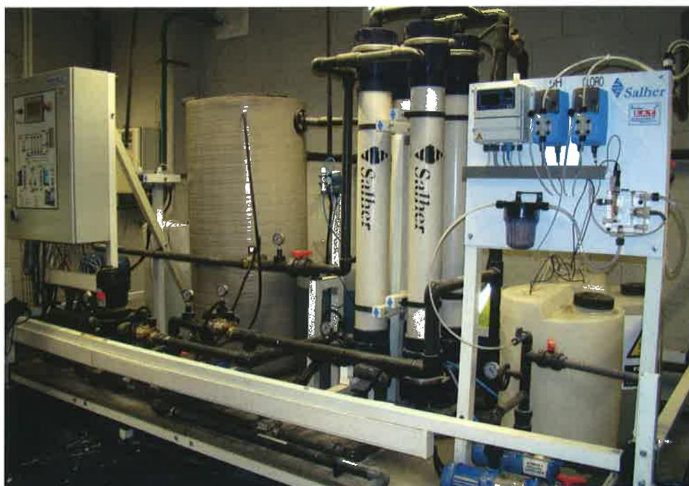
Cette unité compacte d'une capacité de 4 m<sup>3</sup>/h, développée par Salher, traite les eaux de pluie d'un complexe financier à Madrid. Elle permet la réutilisation des eaux de pluie pour l'arrosage des espaces verts ainsi que l'alimentation des WC. Elle est équipée d'un préfiltre, de cartouches MBR d'ultrafiltration (x4) et d'un système automatique de contrôle/régulation de pH, le tout commandé par une armoire électrique avec automate et télégestion.
