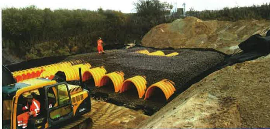
**StormTech de Birco se décline en cinq modèles de capacité croissante. Un tunnel d'isolation situé en tête de système, intercepte le premier flot d'orage le plus chargé en polluants. Ce dernier est muni d'un tissu de filtration qui retient les matières en suspension (MES) et les polluants qui y sont adsorbés.**
