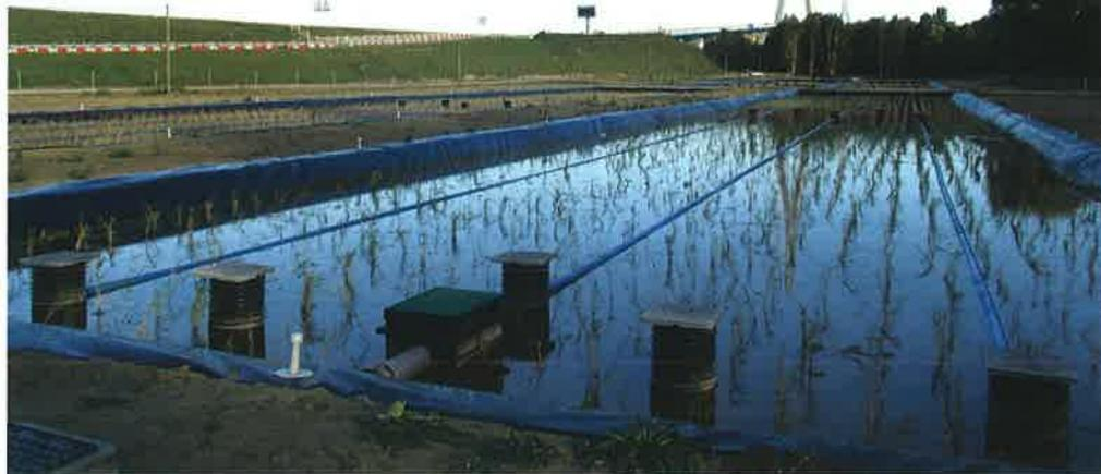
tif de dépollution en amont d'une Saul, de type décanteur dépollueur, seule façon de pérenniser le fonctionnement du bassin de stockage et/ou d'infiltration et d'en extraire la pollution.
