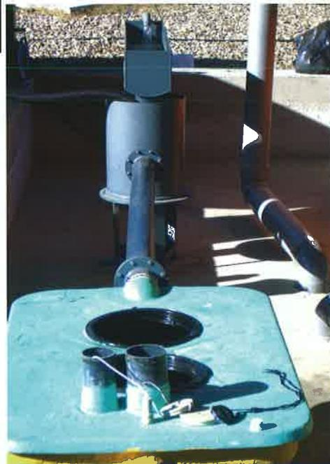
Remosa France réalise des tests d'efficacité selon la norme NF EN-858-1 pour s'assurer que le séparateur sera capable d'absorber le débit maximal et que la concentration maximale en hydrocarbures des rejets n'excèdera pas 5 ppm.
