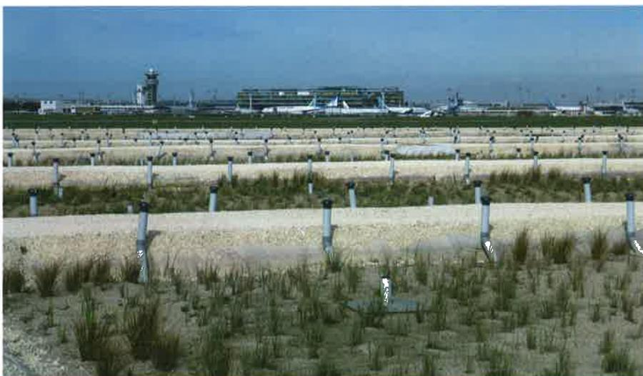
De 3 à 5 millions de  $\text{m}^3$  d'eaux de ruissellement sont collectés et traités chaque année sur la plateforme aéroportuaire d'Orly par le système de traitement des eaux pluviales de l'aéroport. La réalisation d'un marais, grâce à l'expertise d'un groupement d'entreprises, permet à Aéroports de Paris de compléter le traitement physico-chimique de sa Step par un procédé naturel de dépollution dédié aux produits hivernaux.
