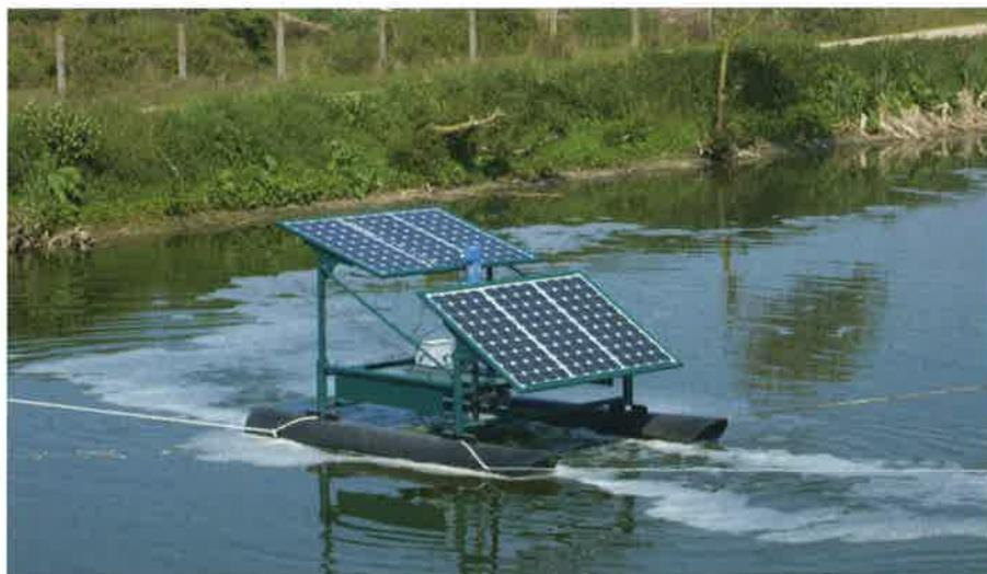
En lagunage, une DBO ou DCO élevée peut créer des conditions d'anoxies totales, génératrices d'importantes nuisances olfactives. En remontant l'hélice d'un aérateur de surface plus près de la surface, Ici le Sungo d'Aquago, le brassage des eaux devient plus efficace, permettant ainsi un meilleur transfert de l'oxygène.
