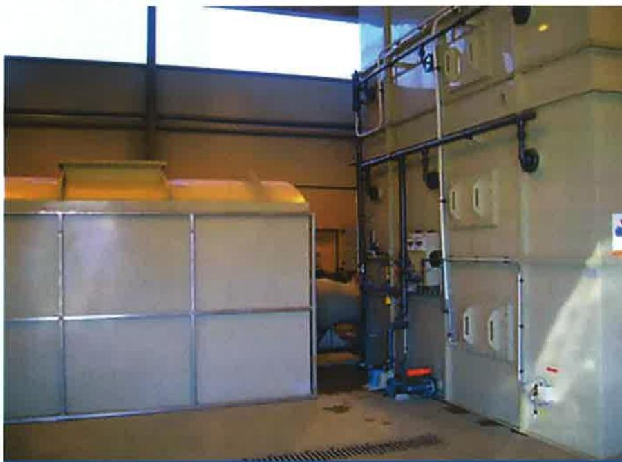
Les filtres synergiques développés par Airepur Industries associent plusieurs modes de traitement pour optimiser les performances et répondre à différentes conditions d'exploitation. Les gains se situent au niveau des consommations de réactifs chimiques, de la limitation des reports de pollution à l'évacuation des eaux, des faibles coûts énergétiques ou encore par leur capacité à pallier les éventuels pics de pollution.
