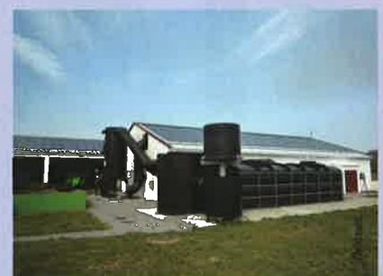
Sur la station d'épuration et le centre de compostage de la commune d'Hasparren (64), la solution proposée par le réseau PROECO2 a permis d'installer une unité de désodorisation composée d'un laveur de gaz, d'un filtre biologique et d'une finitlon au charbon actif, couplé en sortie de process d'un dispositif Eolage<sup>®</sup> réalisé par Delamet.
