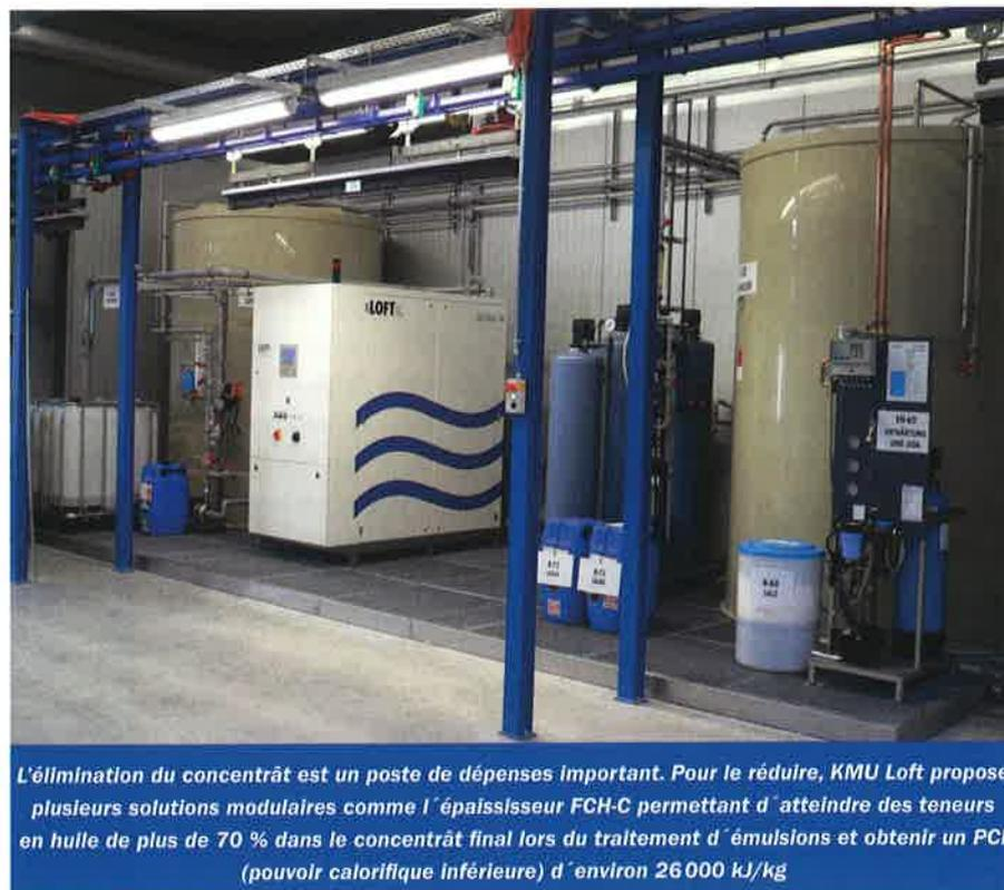
L'élimination du concentrat est un poste de dépenses important. Pour le réduire, KMU Loft propose plusieurs solutions modulaires comme l'épaississeur FCH-C permettant d'atteindre des teneurs en huile de plus de 70 % dans le concentrat final lors du traitement d'émulsions et obtenir un PCI (pouvoir calorifique inférieure) d'environ 26 000 kJ/kg
