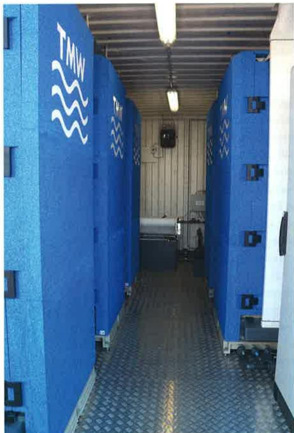
TMW développe une technique d'évapo-concentration à pression atmosphérique et à basse température baptisée MHD. Le module Ecostill™ est composé d'une unité d'évaporation et d'une unité de condensation, d'un ventilateur simple pour la circulation de l'air et d'un dispositif de surchauffe du liquide à traiter.
