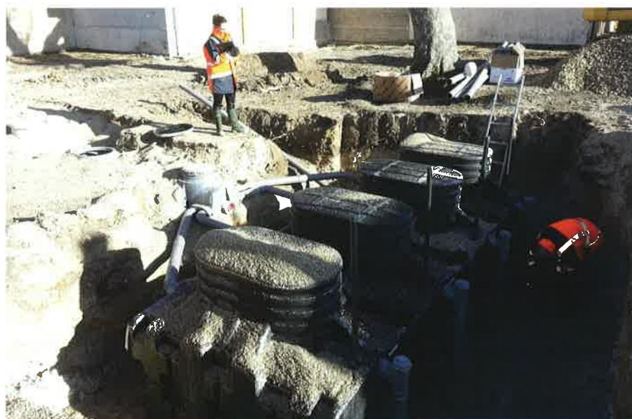
L'Assainissement Autonome associe deux gammes agréées pour mieux coller aux attentes du marché: la gamme Compact'O ST2 (4 à 6 EH) avec fosse toutes eaux double cuve (entre 3 600 et 5 000 litres) et la gamme Compact'O ST (4 à 6 EH) dotée d'une fosse toutes eaux mono-cuve (3 000 et 4 000 litres). Elles s'élargissent vers des capacités plus importantes en filtration (jusqu'à 16 EH), mais aussi en mini-station (de 18 à 48 EH) avec la nouvelle gamme Fluidifix®.
