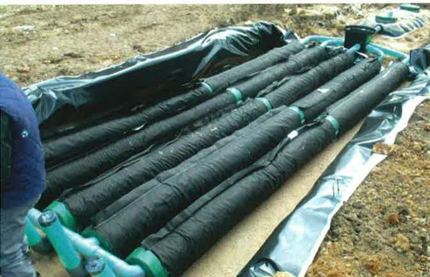
La filière Enviro)Septic ne nécessite ni entretien, ni électricité, ni changement de pièces mécaniques ou remplacement de média.
